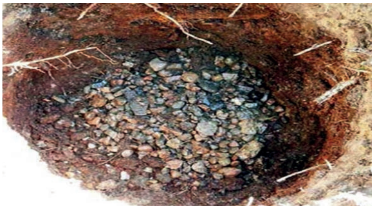
Рис. 3 - Укладка дренажа на дно посадочной ямы
