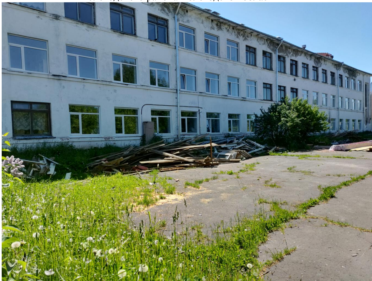
Рис. 3. Ремонт здания. Высажены деревья весной 2017 года в п. Ермаково Вологодского района Вологодской области
