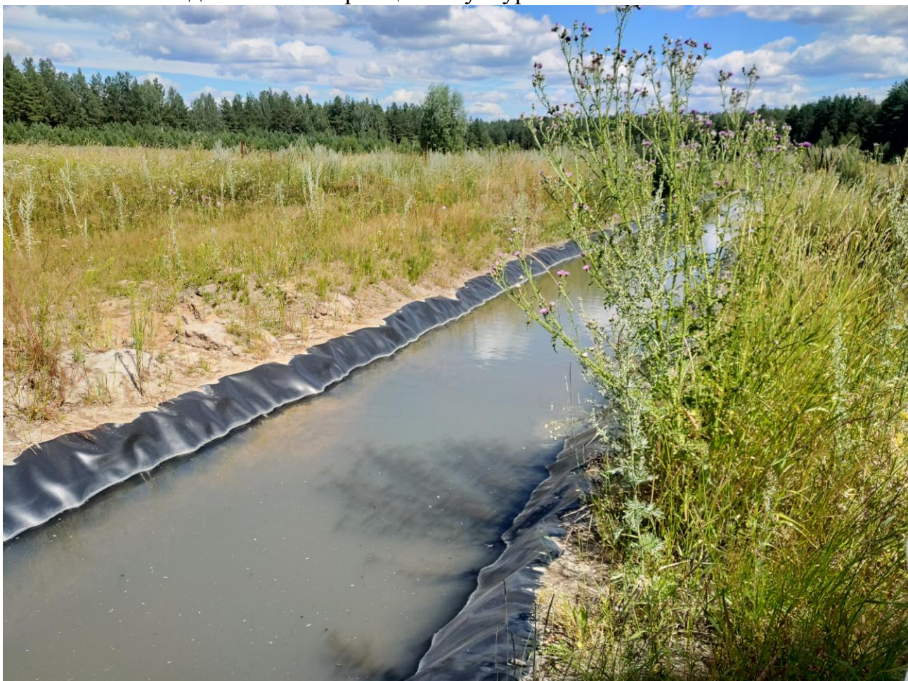
Рис. 5. Прокладка систем водоотведения с фермы. Высажены деревья весной 2019 года вблизи с. Троицкий Сунгур Ульяновской области
